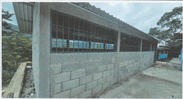
Foto 2: Columnas finalizadas del aula tipo portico
