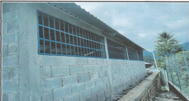
Foto 4: ventanales finalizados del aula tipo portico
