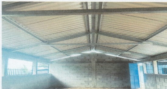
Foto 6: Estructura de techo del aula tipo portico finalizada
