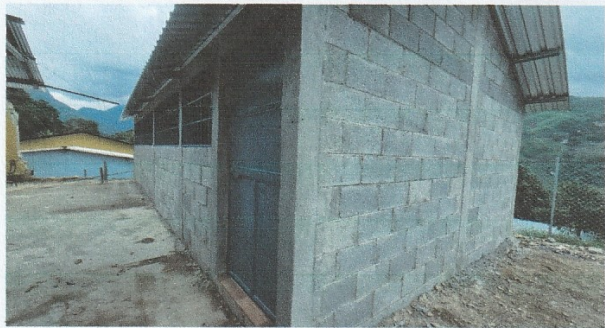
Foto 3: Levantado de pared del aula tipo portico finalizada
