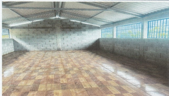
Foto 5: piso instalado del aula tipo portico
